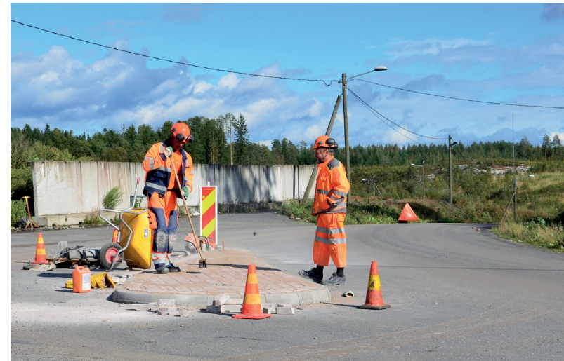
Liikenteenjakkajan rakentaminen jätekeskuksen ympäristielle.
