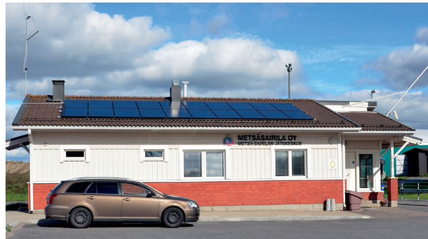
Vaakatoimiston katolle asennettiin aurinkopaneelit
