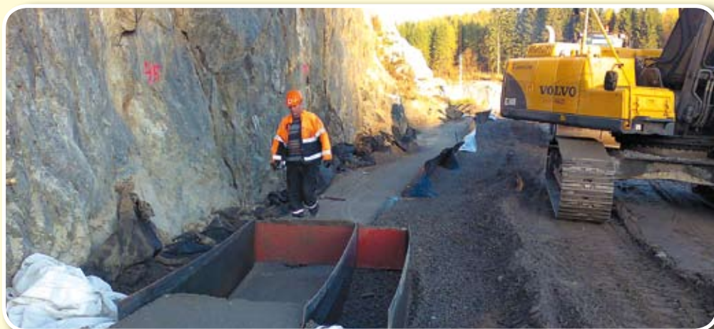
Pystyseinän korotus Metsä-Sairilan jätekeskuksessa.
