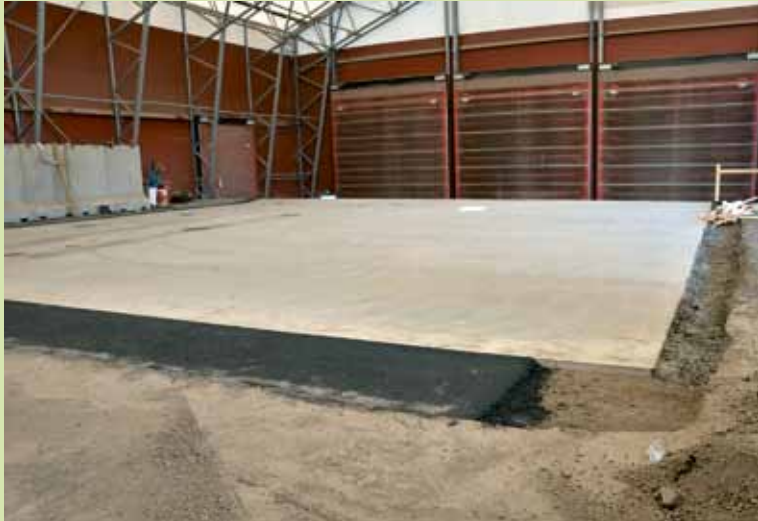
Lajitteluhallin lattia uusittiin.
