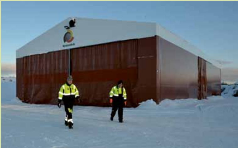
Jätekeskukselle rakennettiin varastohalli.
